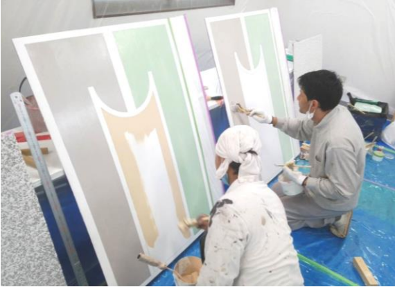
限られた塗料で見本板に合わせ調色(写真上) 調色した塗料を図面に合わせ塗装(写真左)
