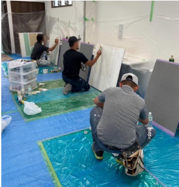
調色した塗料を図面に合わせ塗装
